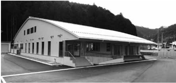
◀ 完成した南部学校給食センター || 金山町金山
