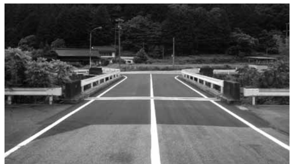
◀ 長寿命化補修を施した小方場橋 || 野尻
