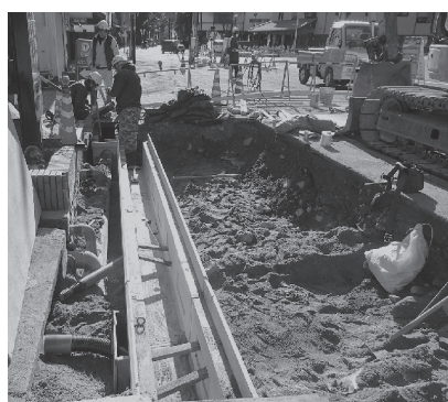
電線の地中化が進められる市道幸田2号線
