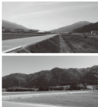
大規模な土地改良事業が行われている羽根地区
