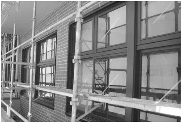
▲外壁のレンガ造り＝旧馬瀬中学校(馬瀬中切)
