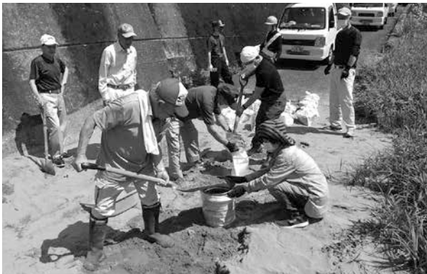
▲土のうづくりを行う住民たち＝保井戸
