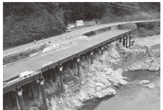
国道41号門原防災事業の工事現場
