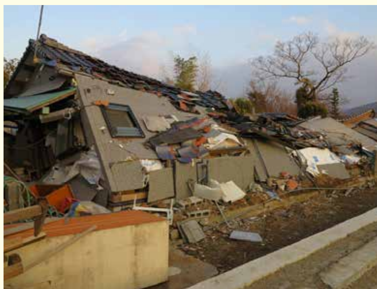
▶熊本地震で倒壊した住宅
