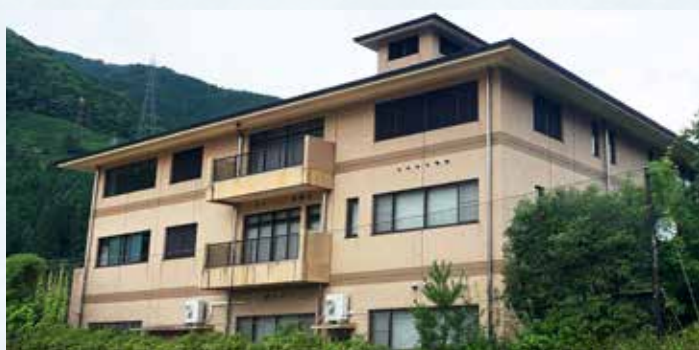
▲湯之島浄化センター（下水道施設）
