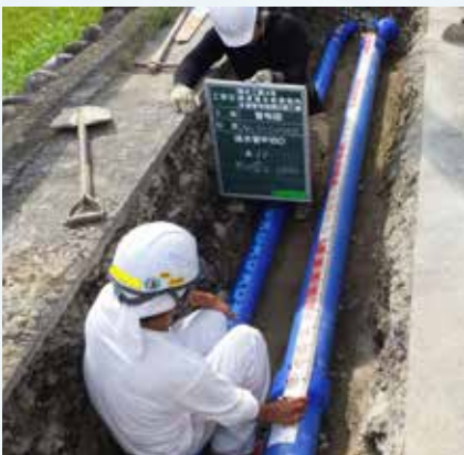
▲水道管の工事
