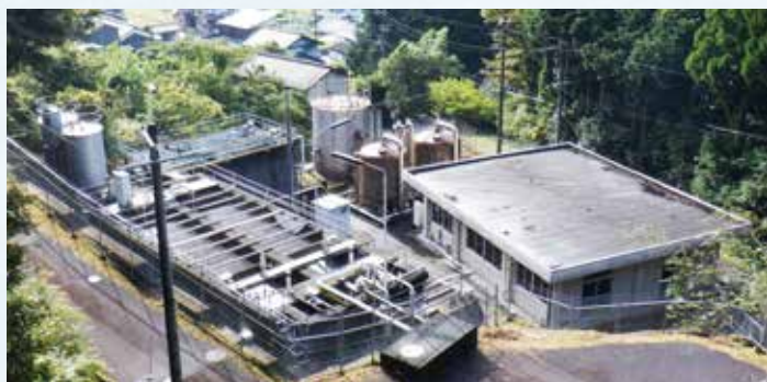
▲金山浄水場（水道施設）
