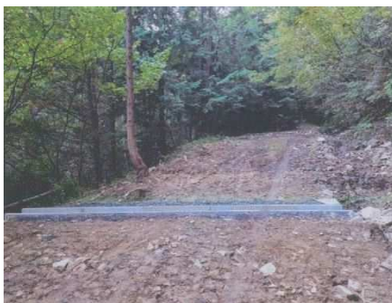
【作業道改好事業】横断工設置
