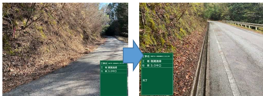
側溝清掃工 施工前
