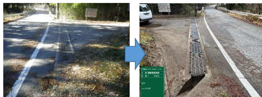
横断溝清掃工 施工前
