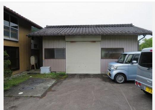
作業小屋 & 車庫
