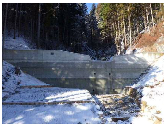
治山事業 堰堤
