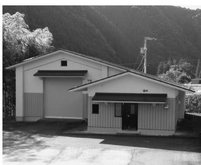
▲農業集落排水施設南地区処理場(金山)
