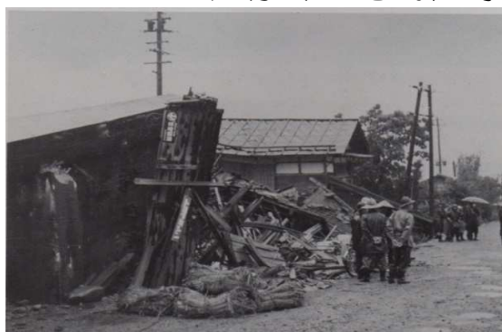
（益田橋の流失時に鋼線が切れ、なぎ倒された民家）
