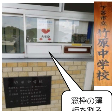
正面玄関左側
