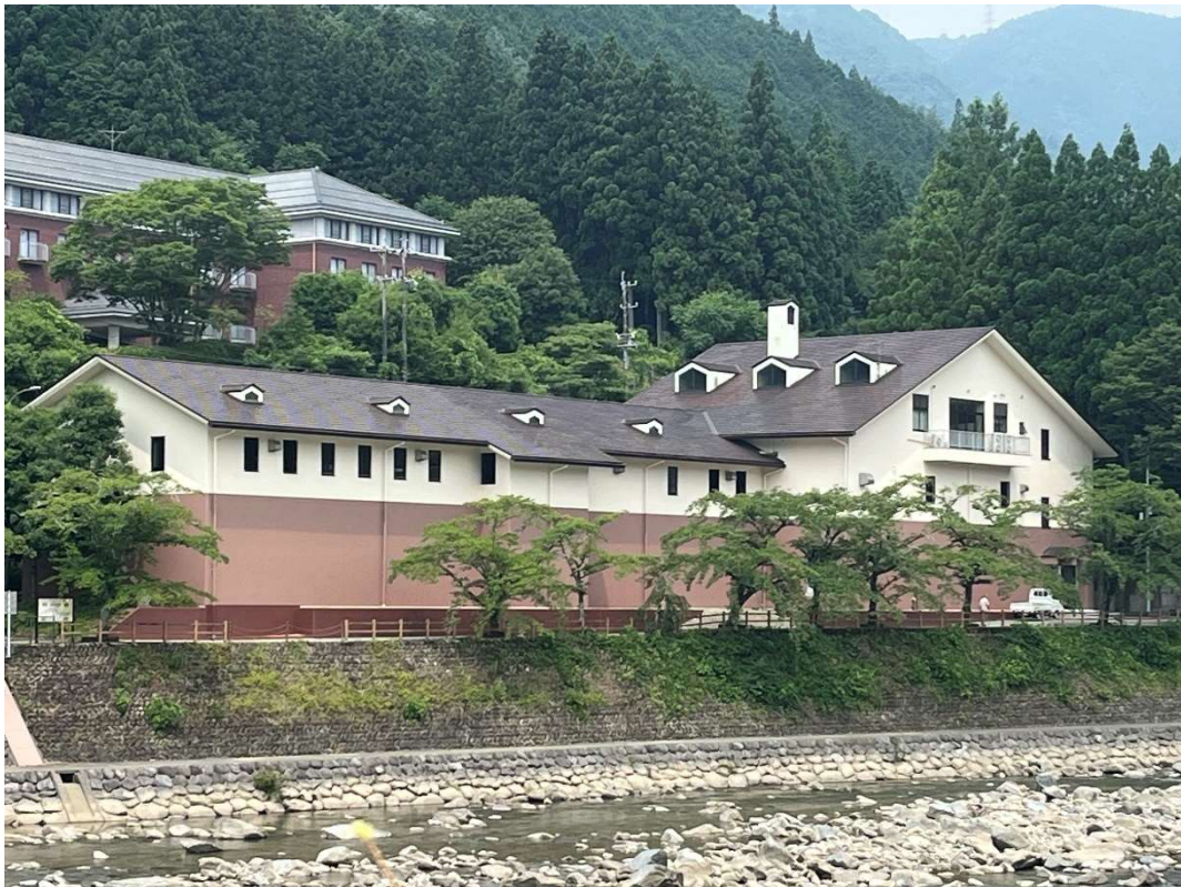
(図表 2-4) 令和 6 年度に耐震工事を完了した「幸田浄化センター」
