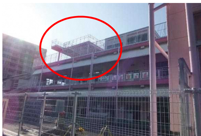
図 15 屋上への避難場所を増築した事例
