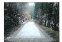
作業道改良事業（路面改良）
