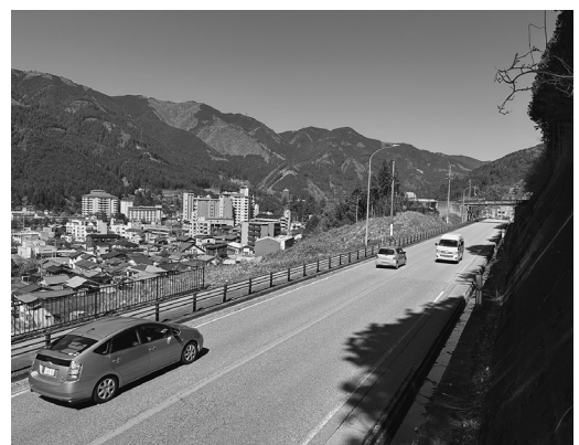
▲国道41号沿線での伐採後の状況
