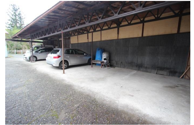
建物裏側 車庫
