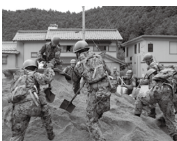
11:00 土砂災害で倒壊した家屋から、土砂を取り除き屋根や壁を破壊し要救助者を救出。救急部隊が搬送。
