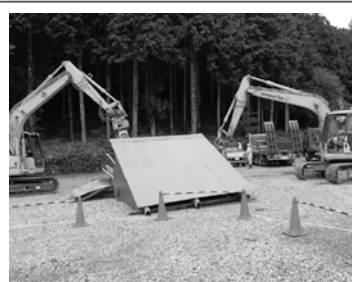
10:25 市道をふさぐ倒壊家屋に要救助者がいないことを確認し、撤去作業を行う下呂建設業協会の重機。
