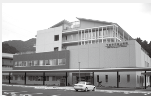
開院間近となった新金山病院
