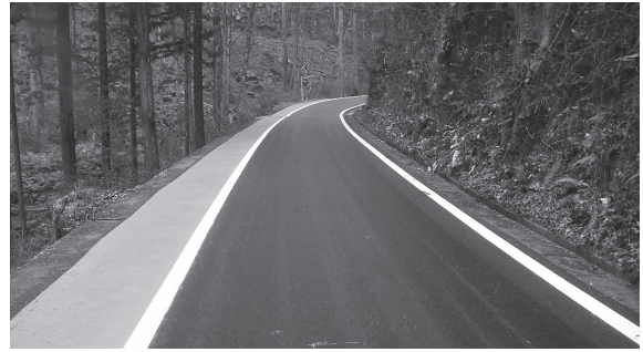
落合8号線舗装修繕工事
