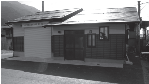
萩原第6分団第1部消防詰所増築工事
