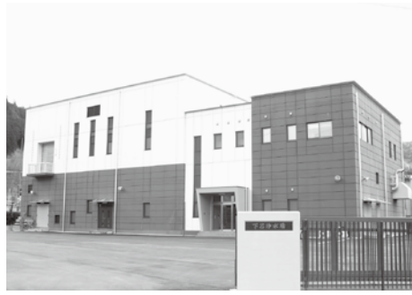
完成した新「下呂浄水場」
