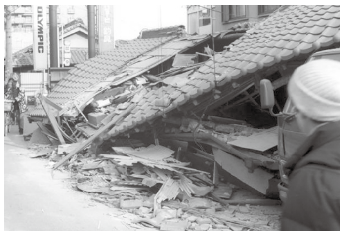
写真 1) 阪神・淡路大震災で倒壊した家屋
