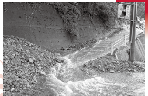
道を通る土砂や水（小坂・大垣内地区）
