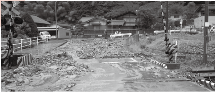
山から流れ出した土砂で埋まったJR高山線踏切（萩原・西上田地区）
