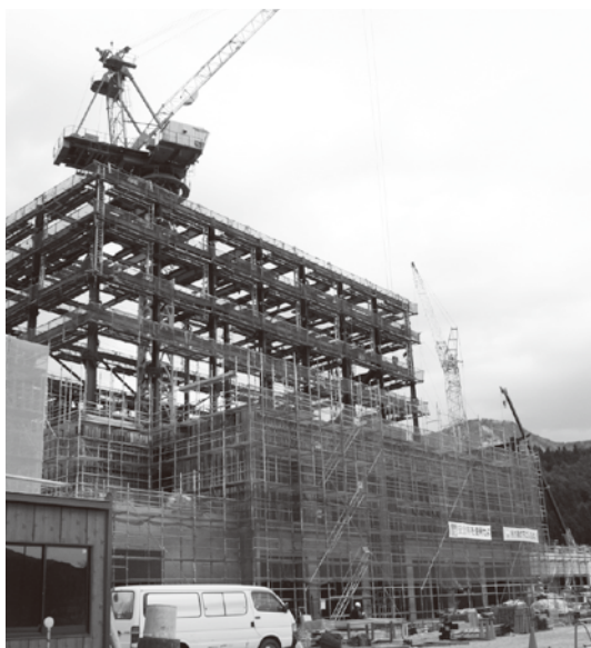
▲建設工事が進む下呂交流会館「アクトピア」
