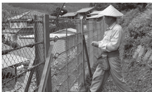
馬瀬地域で設置された防護柵
