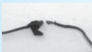
火元となった結線部分
