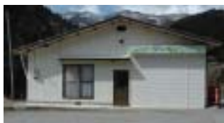
山之口子ども育成連絡会の活動拠点「ぶちクレヨンハウス」。空いた消防詰所を改装して、再利用しています。
