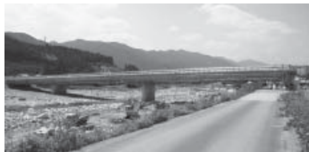
整備が進む花池～跡津間の新橋 〔延長283m・2車線片側歩道〕
