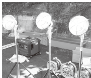
購入品内訳：テント4張、マンホールトイレ3台、パーソナルテント3張、発電機1台、投光機3台
