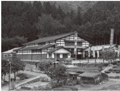
東濃地方地歌舞伎芝居小屋の明治座(中津川市加子母)
