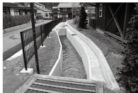
尾崎 3 区地内排水路改修工事
