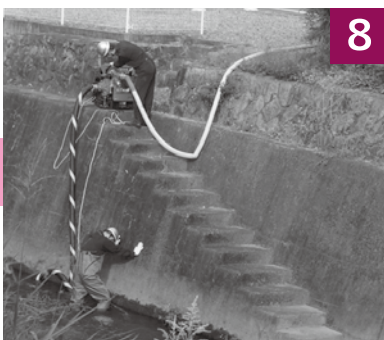
8 河川の脇まで可搬ポンプを運び、吸管を河川に投入し、消火用の水を吸水する消防団員
