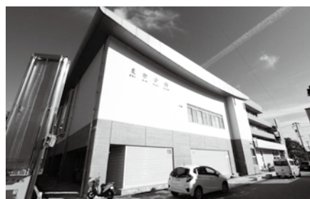
星雲会館耐震改修等工事
