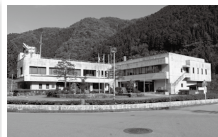
馬瀬中央公民館耐震改修等工事
