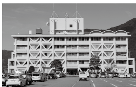
下呂総合庁舎改修工事
