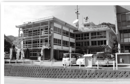
小坂振興事務所耐震改修工事
