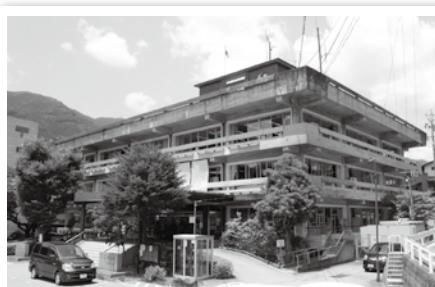
下呂庁舎耐震改修工事
