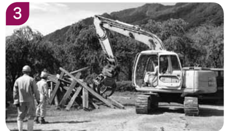
応援要請を受けた建設業協会が重機を持ち込み、大きながれきを撤去。
