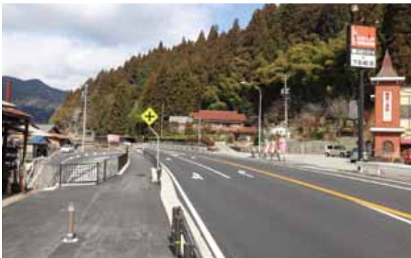
下り車線に右折レーンが設置され、下呂交流会館や県立下呂温泉病院への通行がスムーズになった交差点＝小川、国道41号小川交差点
