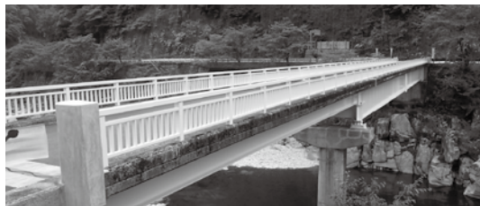
◀ 塗装塗替や橋台・橋脚補修などで長寿命化を施した久野川橋 久野川
