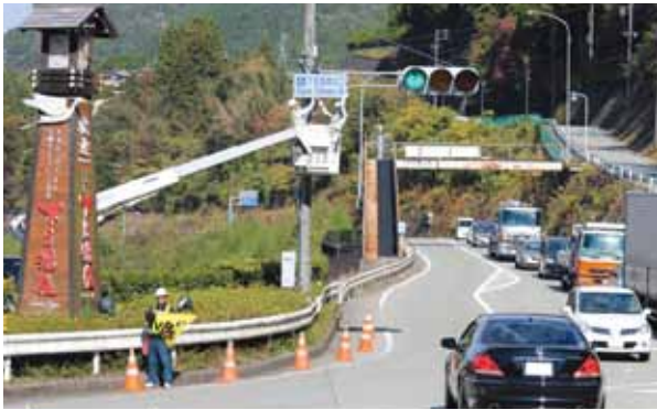
「東上田」から「下呂温泉北口」の標識に取り替えられる国道41号下呂トンネル北側交差点=東上田、国道41号
