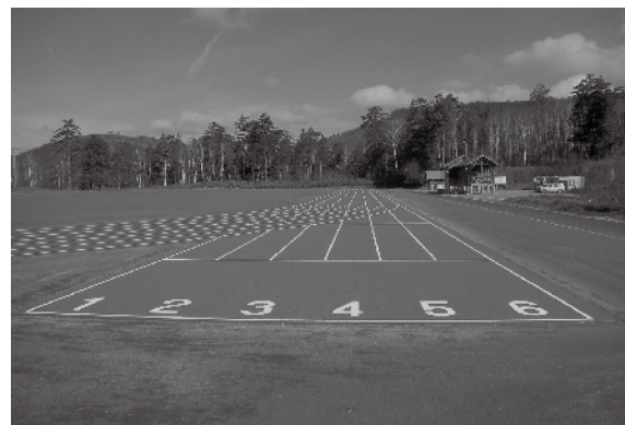
◀舗装を張り替えた400mトラック || 飛騨御嶽高原高地トレーニングエリア
