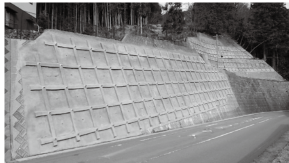
◀構造物補修工事を実施した市道小川 2 号線Ⅱ小川
