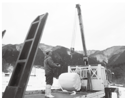
▲作業は一人で全部行うとのこと。手際よく積み込みをされています。
