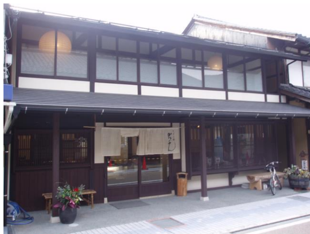
古民家の前面を再生した建築物（かつぶん）
