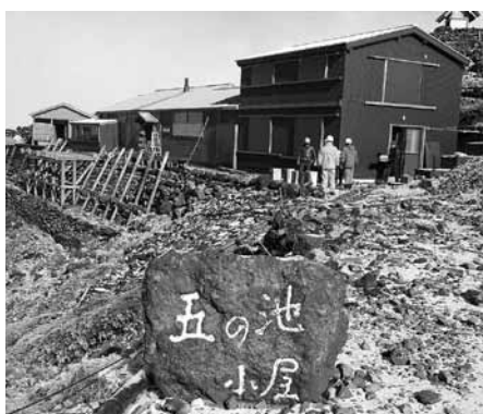
入山規制の区域外となった五の池小屋
