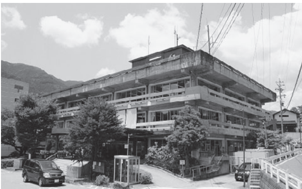
建築から49年経つ下呂市役所下呂庁舎
