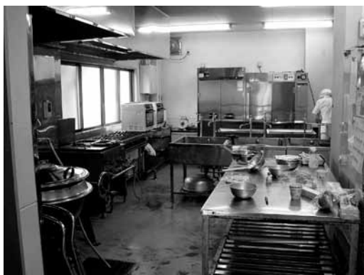
改修されるわかば子ども園調理室
