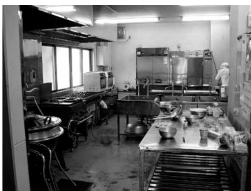
改修されるわかば子ども園調理室
