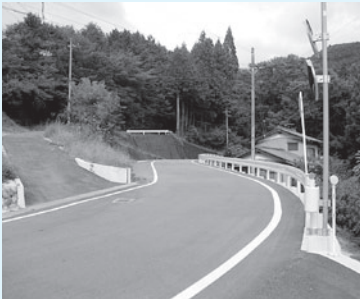
拡幅された東上田1号線
