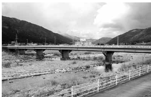
耐震補強工事を行う朝霧橋（萩原地域）
