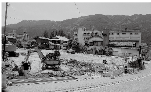
市営駐車場とするため整備中の阿多野駐車場（6月撮影）
