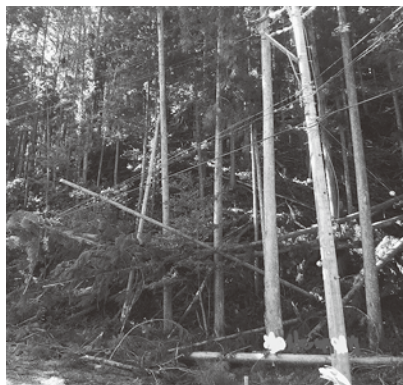
停電対策が必要な道路沿いの山林
