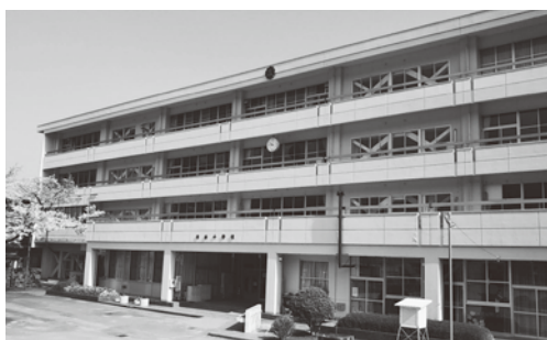
統合後の校舎となる現在の金山小学校校舎
